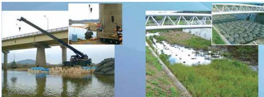
写真3 橋脚根固め・護床事例 (左：橋脚根固め、右：護床工)
