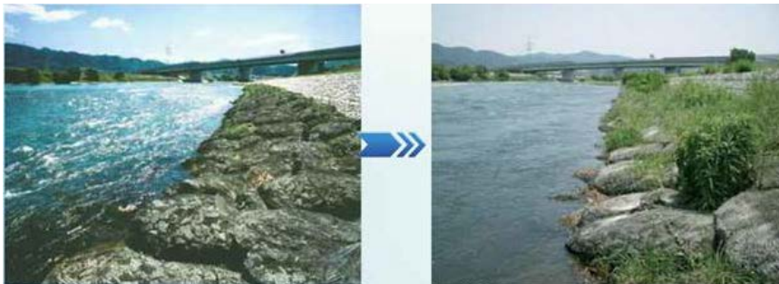
写真2 根固め事例 (宇治川) (左：施工直後、右：施工後20年)
