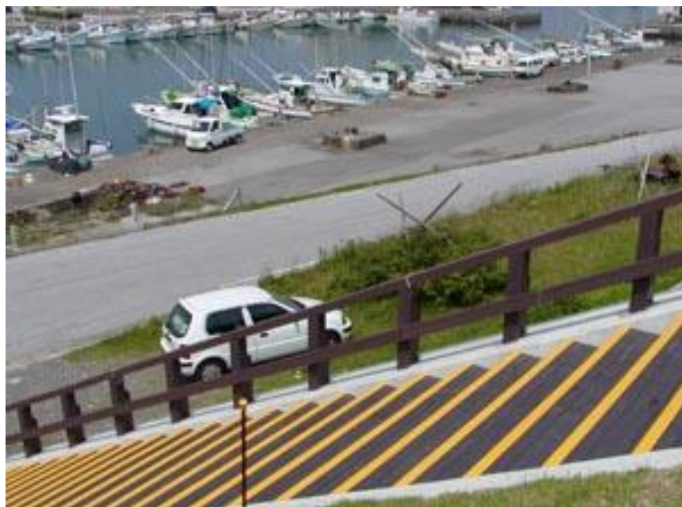
高知県吉川村堤防整備工事 『階段・手摺』(高知県吉川村)
