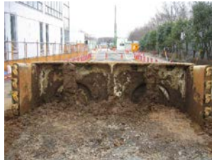
アプローチ掘進状況
