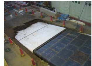
アプローチ→トンネル掘進状況
