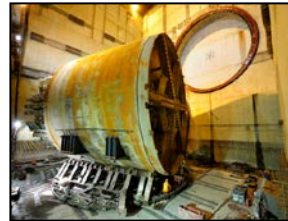
シールド機 回転状況
