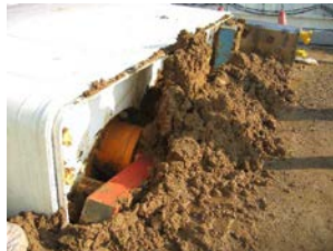
アプローチ掘進状況
