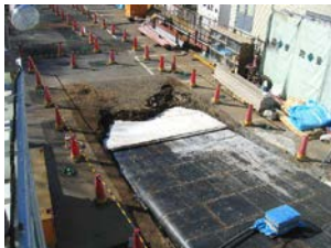
トンネル掘進状況
