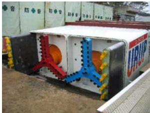
シールド発進状況
