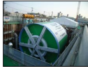
シールド機 発進前
