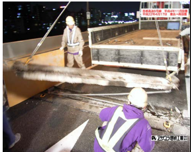
《コンクリート撤去の状況》
