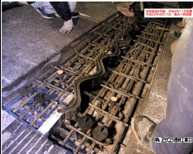
《リペアコントをセットした状態》
