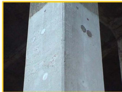
脱塩を適用した橋脚の状況 旧国道8号線洞川橋経年比較
