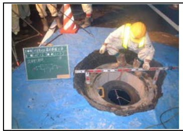
開口蓋撤去後
