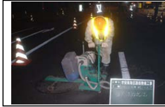
1) 舗装切断工
