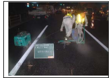
7) 舗装切断工
