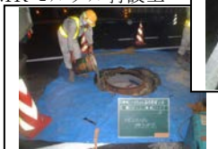
11) MRモルタル打設工
