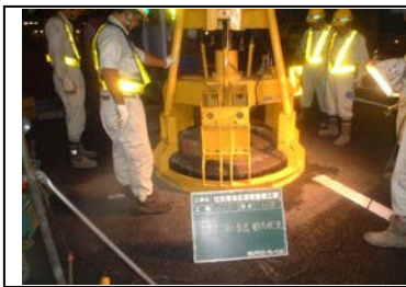
8) 開口蓋撤去工
