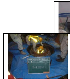
9) 人孔受枠据付工
