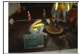
9) 人孔受枠据付工
