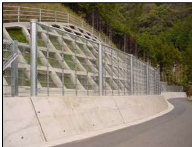
擁壁上—支柱直型 (愛媛県宇和島地方建設局) H=3.0m L=94.7m E=385kJ
