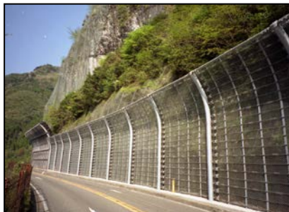
道路脇—支柱曲型 (熊本県球磨地域振興局) H=7.0m L=78.0m E=150kJ
