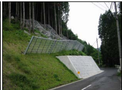
斜面上—支柱斜型 (大分県大分土木事務所) H=2.5m L=48.0m E=400kJ
