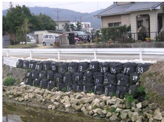
耐候性大型土のう「ツートンバッグ」施工例
