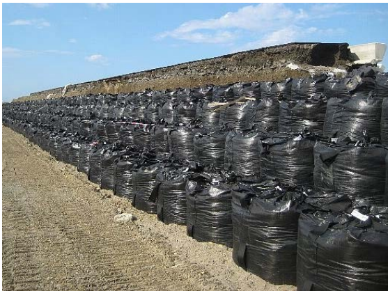
耐候性大型土のう「ツートンバッグ」施工例
