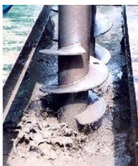
新工法の施工状況
