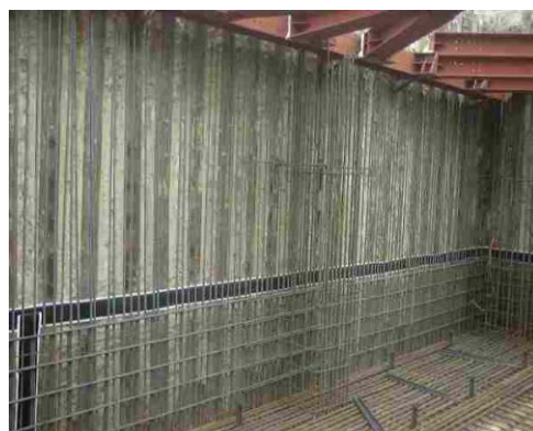
掘削時の壁面写真
