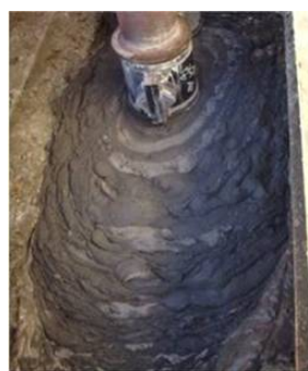
従来工法の施工状況
