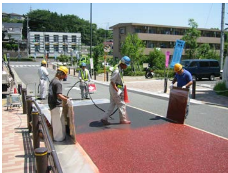
ポーラスニート施工状況 東京都町田市
