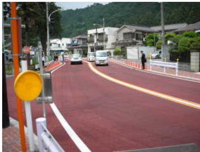
ポーラスニート施工例（青梅市内）
