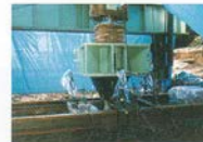
押し込み載荷装置
