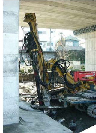
写真-1 施工状況
