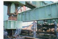
押し込み載荷装置
