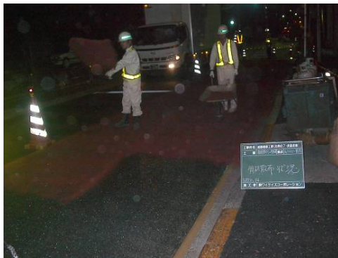
骨材散布状況
