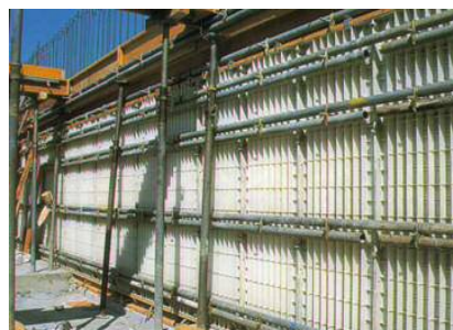
カタパネル施工例
