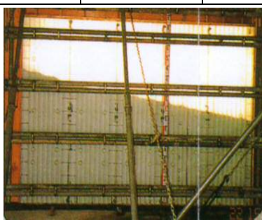
打設状況が見えます
