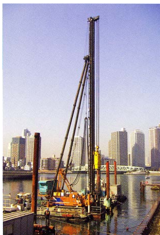
写真-1 施工状況（豊洲運河）
