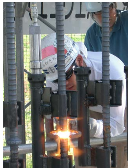
写真-3 エコウエルガス圧接作業風景
