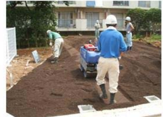
③振動ローラーによる転圧。
