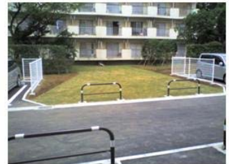
④グラスミックスの施工完了後に芝を施工
