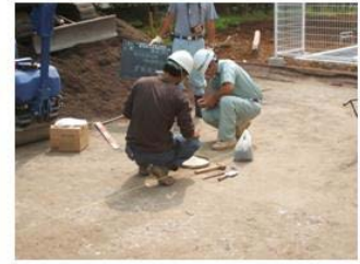
①路盤締め固め後の密度管理
