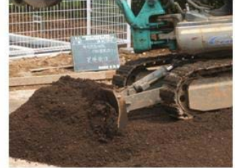
②グラスミックスの敷均し
