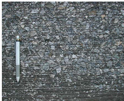
写真-5 TSファイン・ミリングの切削面 (同左工事)
