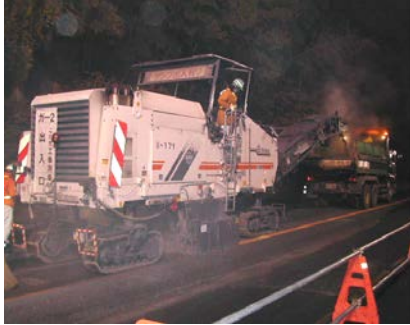
写真-4 切削面での交通開放時の安全性向上 (国道51号千葉市内) (承認採用)
