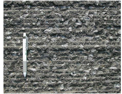
写真-6 通常切削機の切削面 (同左工事近くの別切削工事箇所)
