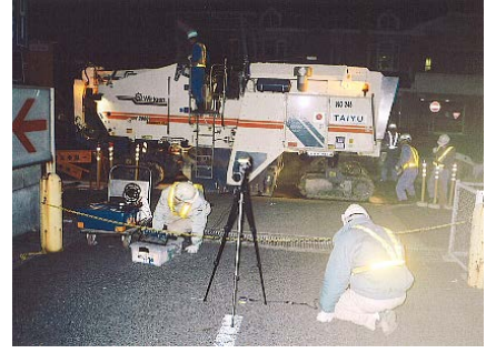
写真-3 住居・病院近傍地域で夜間切削時の騒音測定 (名古屋市天白区内, 原設計採用)
