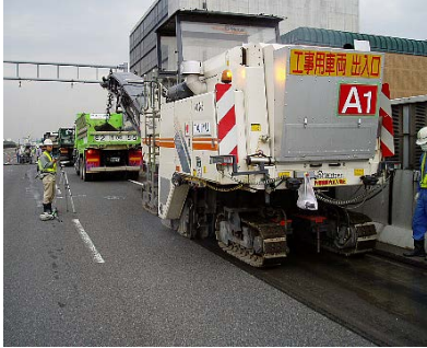
写真-1 名古屋高速高架橋の舗装切削時の騒音対策 (元設計で採用)
