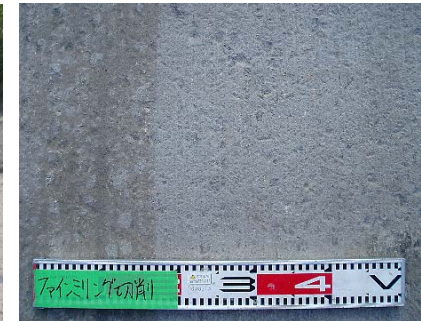
写真-9 名古屋市内コンクリート床版橋での舗装切削面 (変更採用)
