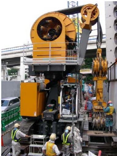
作業帯占有幅 6m での施工状況
