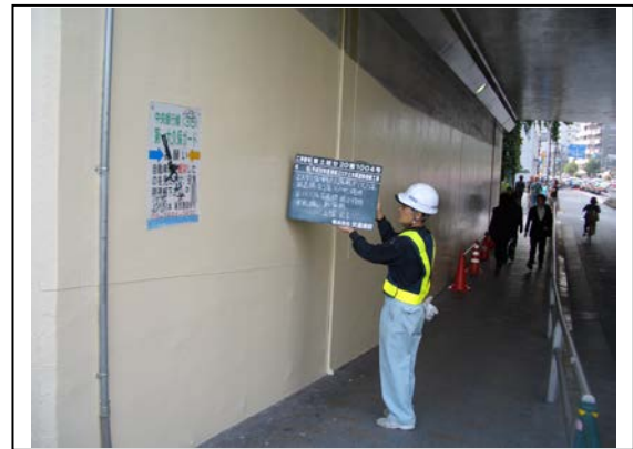
上塗り完了(中塗り2層目完了後に施工)
