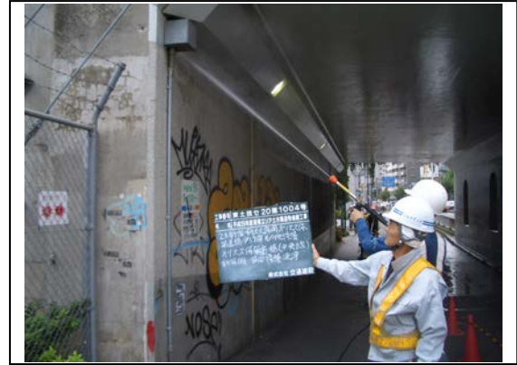
上塗り完了(中塗り2層目完了後に施工)
