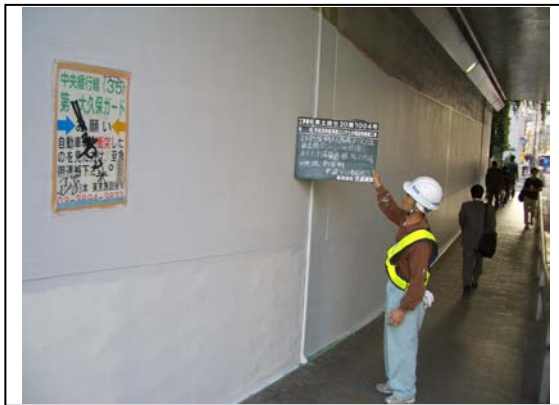
中塗1層目(下塗り完了後に施工)
