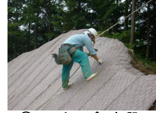
③ アンカーピン打設
