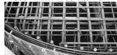
写真-4 ケーソン頂版せん断補強筋に適用
