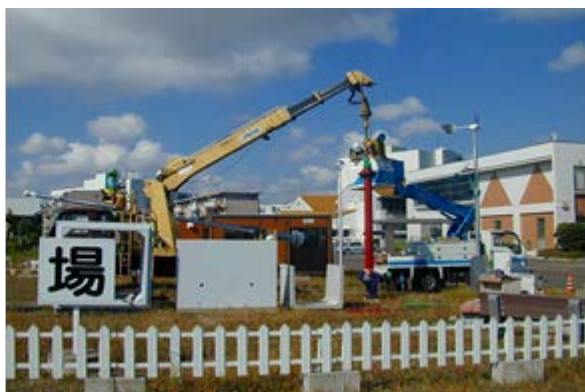
鋼管杭装着状況
