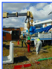
回転・圧入状況
