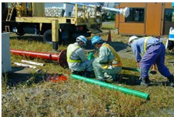
オーガー挿入状況
