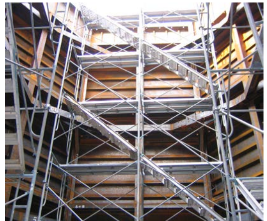
写真-2 鋼製パネルの内部 (尾竹橋)
