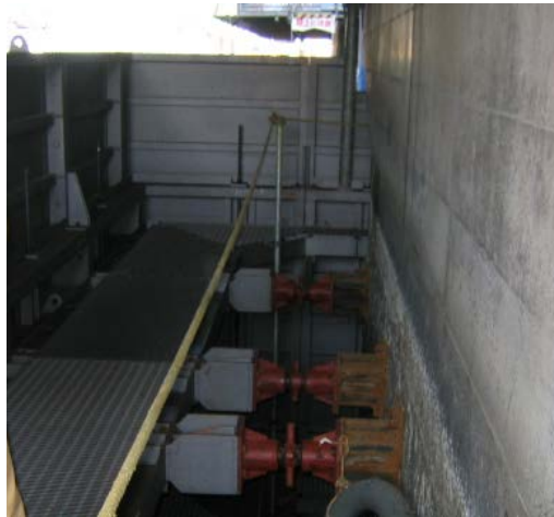
写真-3 支保工（足場兼用）
