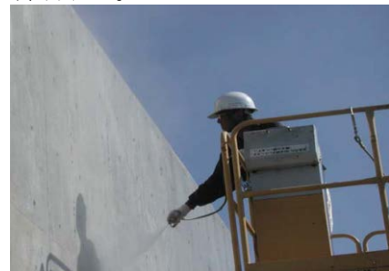
写真1 表面含浸工法塗布状況写真
