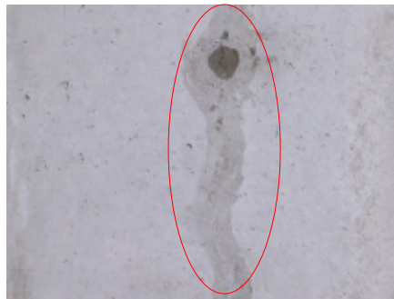
写真-3 自動式低圧注入工法の補修
