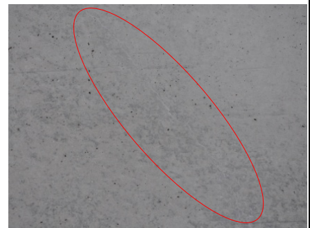
写真-4 圧力調整注入工法の補修跡
