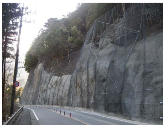
写真-2 東京都内での施工実績
