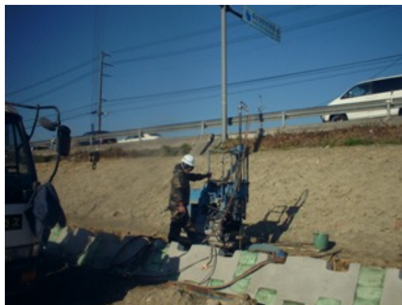
写真-1 特殊注入管設置状況
