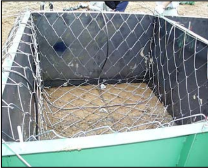
写真-2) 型枠設置
