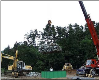
写真-4) 吊上げ・転置
