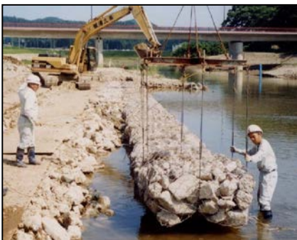
写真-6) コンクリート殻使用によるリサイクルの促進事例
