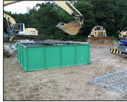
写真-3) 中詰め材投入
