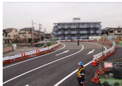
仮設切回し道路（写真左が旧豊島）
