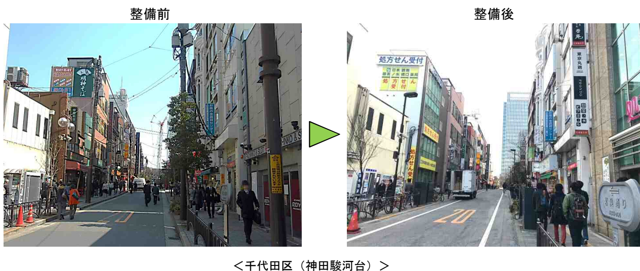
図 3-10 都市再生特別地区を活用して開発区域を超えた周辺道路を無電柱化した事例
