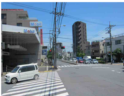
図 1-1 林立する電柱と輻輳する電線
