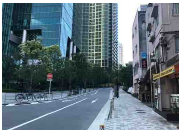
図 2-8 開発プロジェクトに合わせて無電柱化された事例
