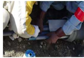
接着剤塗布作業
