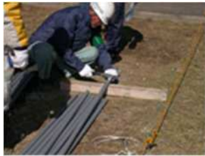
ダミーさや管切断作業
