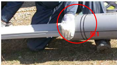
セパレータの挿入
