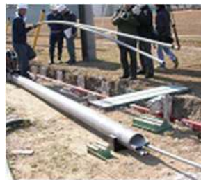
さや管の挿入
