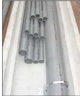
図3-9 さや管敷設写真
