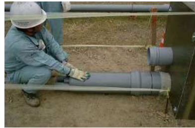
図2-6 ボディ管用ダクトスリーブへのロータス管の挿入
