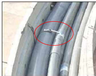
図3-10 ステンレスバンドによるさや管固定写真
