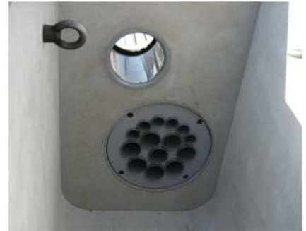
図2-9 特殊部内から見たボルト固定式ロータス管の取付状況
