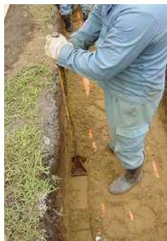
図3-4 埋戻し工施工写真②
