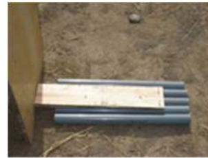
セパレータ移動防止治具とダミーさや管
