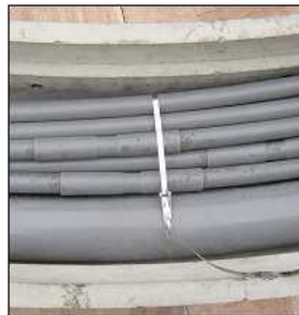
図3-11 ステンレスバンドによるさや管固定写真
