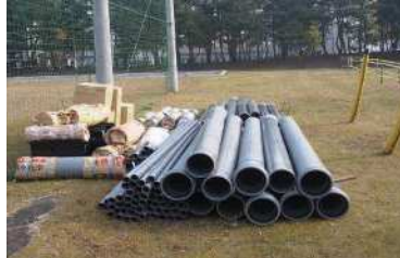
図2-5 使用材料等の現場搬入写真
