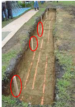
図3-3 埋戻し工施工写真①
