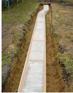
図3-13 落とし蓋目地の養生写真
