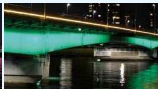
右岸下流側からのぞむ
