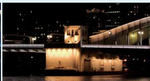
橋脚の操作室
