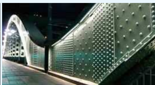
アーチリブのリベット
