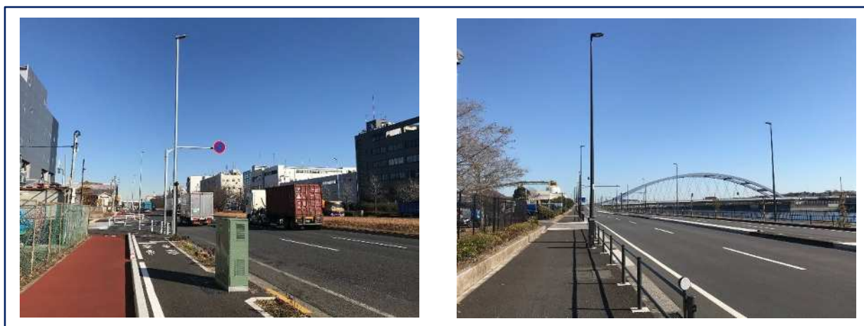
図IV-7 臨港道路の無電柱化状況（新木場地区、海の森地区）
