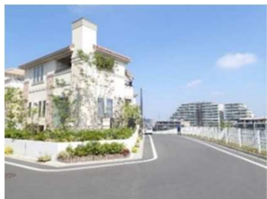
図IV-21 土地区画整理事業による 無電柱化事例 (稲城市東長沼 南山東部地区)
